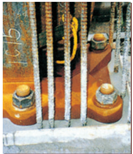
18. ボルト締付け完了
