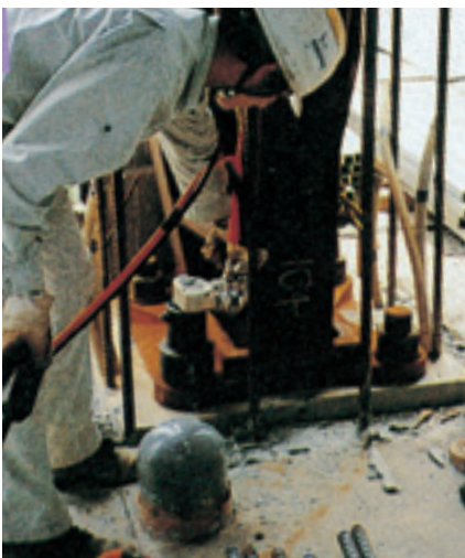
16. 油圧式トルクレンチによるボルト締付け
