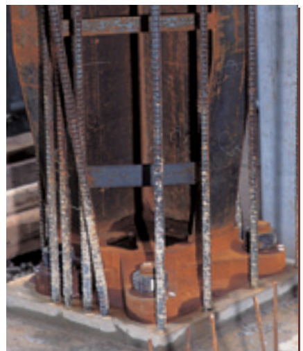
18. ボルト締付け完了
