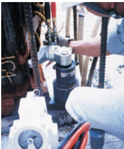
17. 油圧式トルクレンチによるボルト締付け
