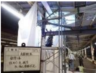
図 2 溶接作業の火花対策
