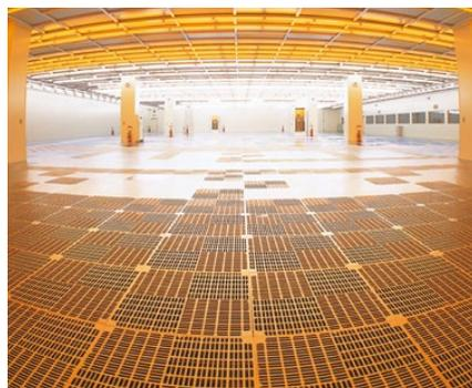
半導体をはじめ各種精密分野では塵埃を排除するクリーンルームが不可欠です。豊富な経験と実績により、重量化の進む機器にも対応できる超荷重パネル等多様化するお客様のニーズに対応いたします。
