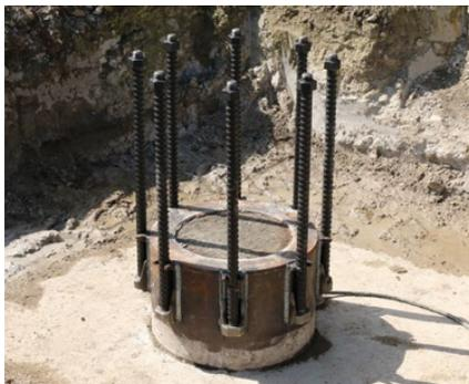
ジョイントカブラ工法は、太径の高強度定着アンカーとジョイントカブラの効果により、大きな耐力を確保できます。耐力確保により高強度杭の使用が可能となります。また、在来工法と同耐力とする場合は、定着アンカーの本数が減少し、上部構造の鉄筋との干渉を抑えることができます。
