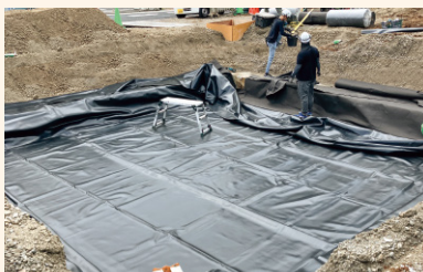
5 遮水シート敷設
