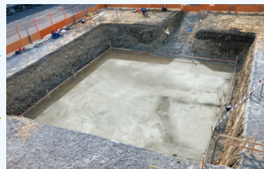
3 基礎コンクリート ※浸透の場合は砂
