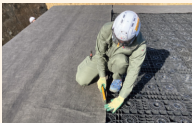
11 側面、上面透水シート敷設
