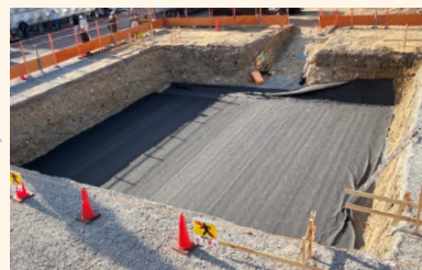
6 内面透水シート敷設
