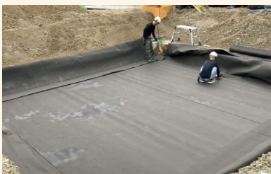
4 外面透水シート敷設
