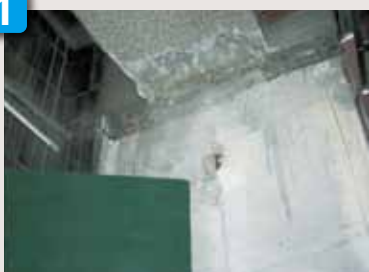
仕上材撤去・目荒らし
