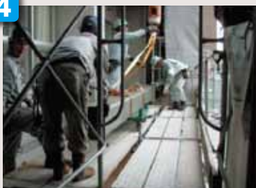
吊込み・人力による横持ち
