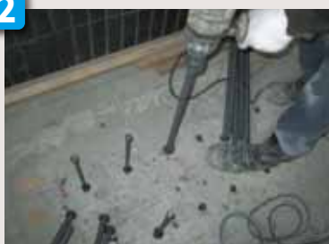
あと施工アンカー打設
