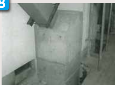
接合部・ブレース コンクリート打設
