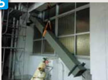
ブレース設置
