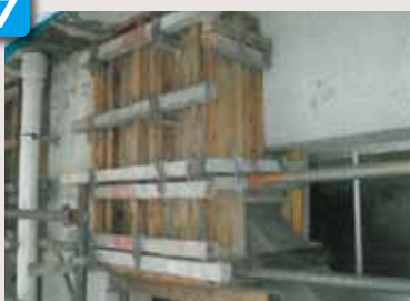
接合部 型枠工事
