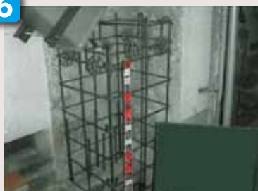
接合部 配筋工事
