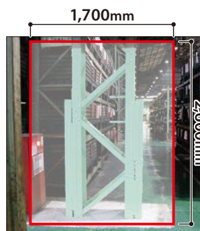
根巻柱脚補強
