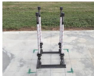
③ アンカーボルトの組み立て
