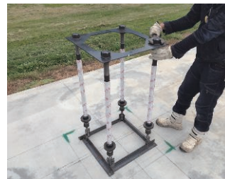
④ 形板の取り付け
