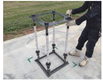
④ 形板の取り付け
