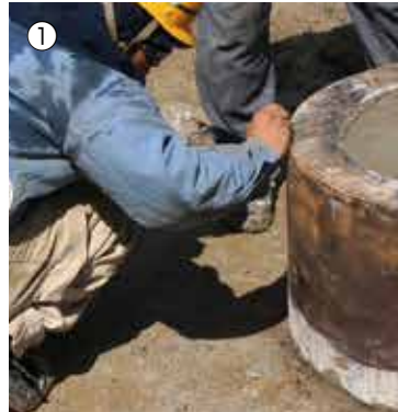
取付け位置マーキング
