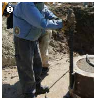
定着アンカーねじ込み
