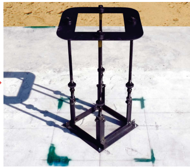
アンカーボルト設置完了
