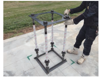
④ 形板の取り付け
