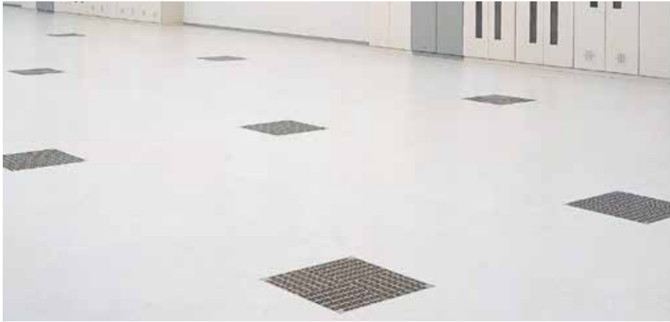
DC用フロアの施工例
