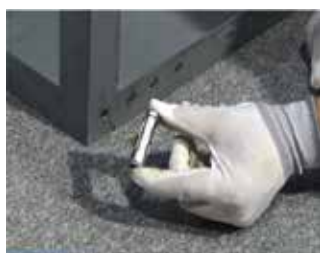
④パネルアンカーの取付
