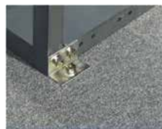
⑥固定完了
