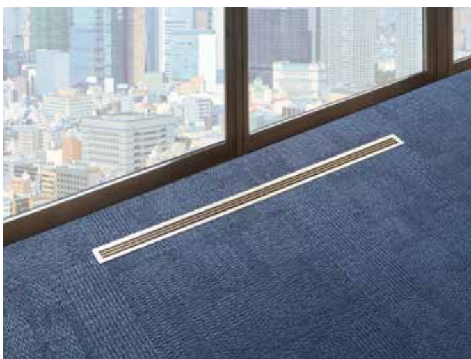
スリット型床吹出口取付イメージ
