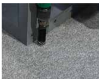
②仕上げ材の孔明加工
