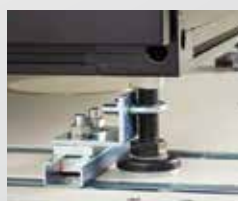
耐震構造の建物にはしっかり固定のUボルト金具
