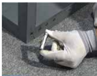
④パネルアンカーの取付
