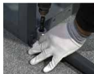
③OAフロアの孔明加工
