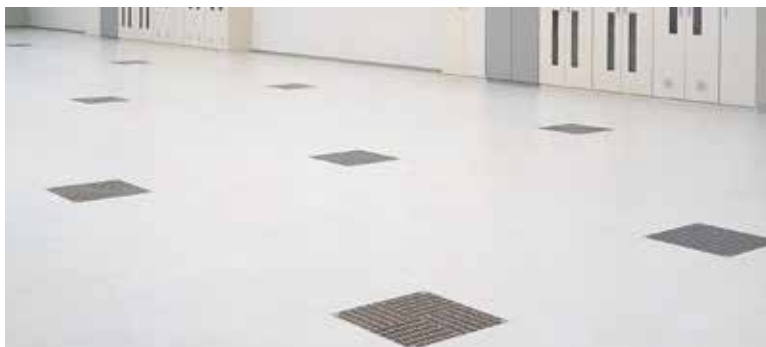
DC用フロアの施工例
