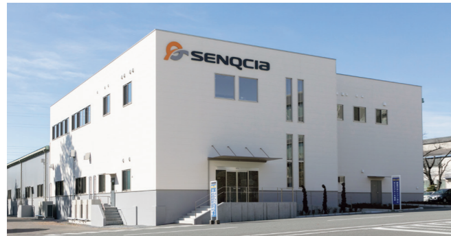
2023年には新棟を建設し、主にフロアパネルの生産を行っています。 The newly established factory in 2023 mainly produces floor panels.
