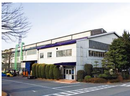
埼玉・熊谷市 センクシア(株)関東製作所
