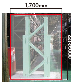
根巻柱脚補強
