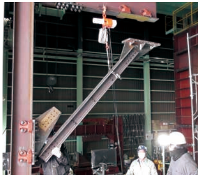
5 プレート・方杖取付け
