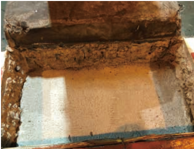
1 基礎コンクリート掘削
