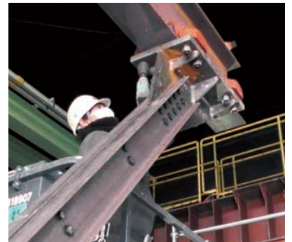
6 高力ボルト締付け
